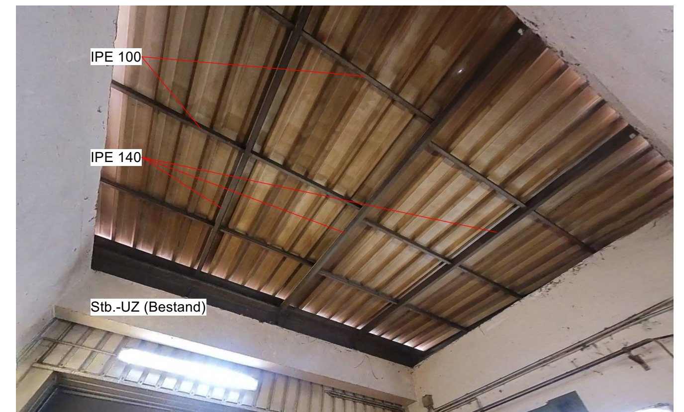
Unterseite , mit Blick auf Kellerwand (Bauachse 6) (Bestand)
